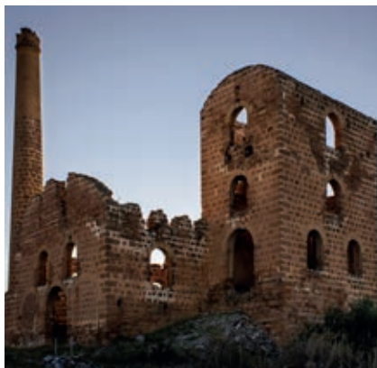
Ruina de una mina en Linares (Jaén).
